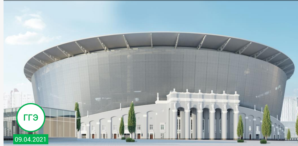
Реконструкция спортивного комплекса «Екатеринбург Арена», объект культурного наследия, г. Екатеринбург, 61 890 м 2 АГК, стадия «П», стадия «Р»
