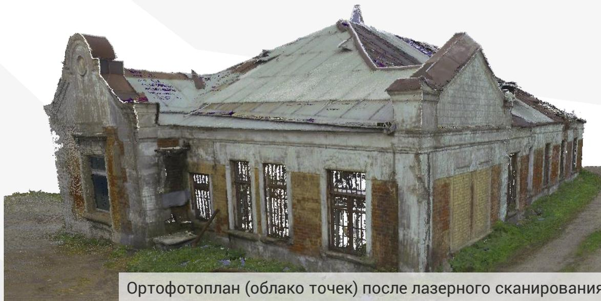
Ортофотоплан (облако точек) после лазерного сканирования
